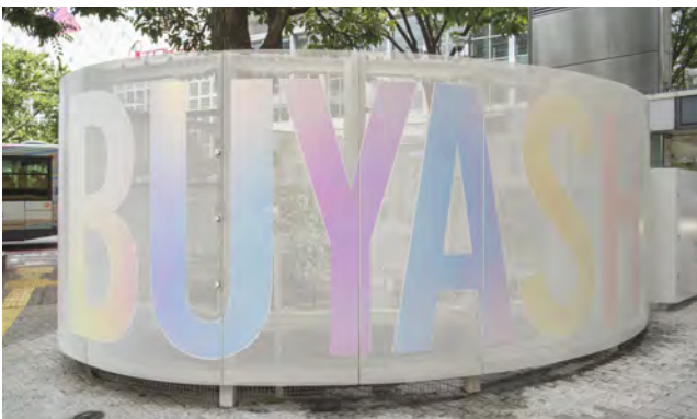
▲「渋谷地下街 仮設空調室外機置場フェンス」
