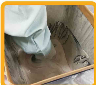
ヘラでかき混ぜます、かき混ぜた後 30 分程度放置すると固化します。
