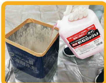
廃棄するウレタン系床糊に床用EGロックUを規定量入れます。
