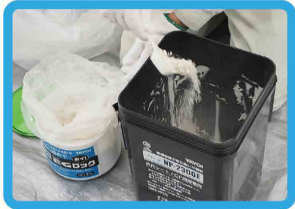
廃棄する水性系床糊に床用EGロックを規定量入れます。
